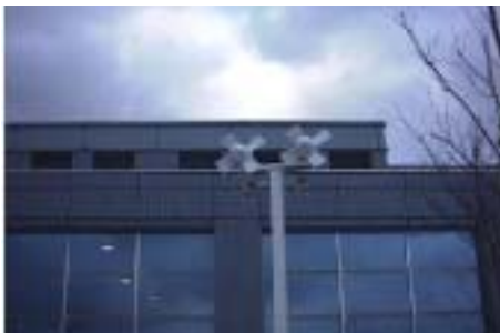
図1. 工科大に設置された試験機。プロペラの直径は50cmで軽量、発電システムの低コスト化が実現されている。(株)フジタとの共同研究。
