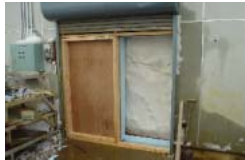
図3. 柏崎市鶴川の仮設雪室。室内は2以下、湿度95%の状態が保たれている。現在は、インターネットWeb上の操作により情報の取得が容易になっている。
